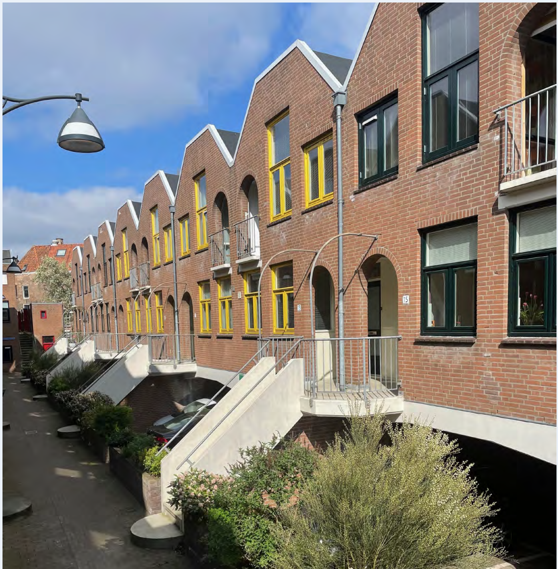
De woonwijk Onder de Bogen in Zwolle. Foto: Het Oversticht.
